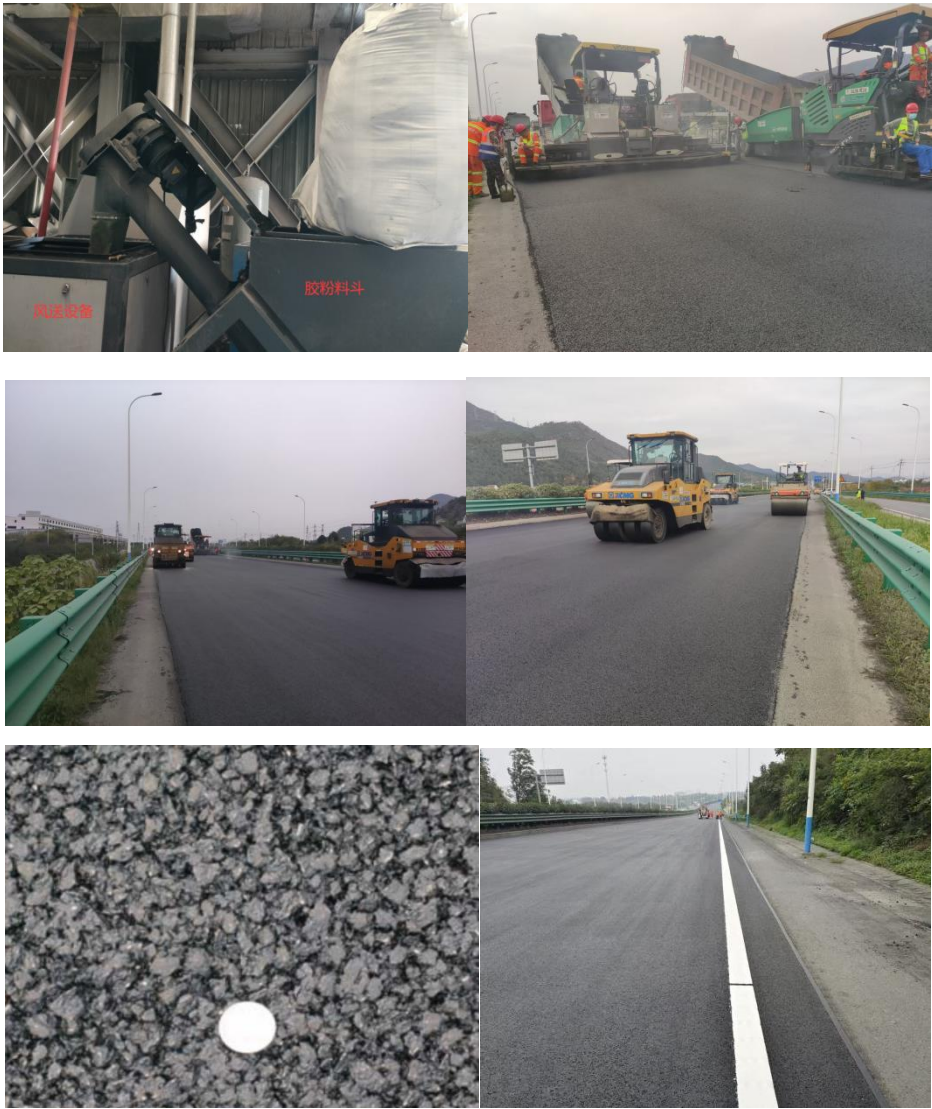
图 E.5 ECA-10 拌和、摊铺、碾压
