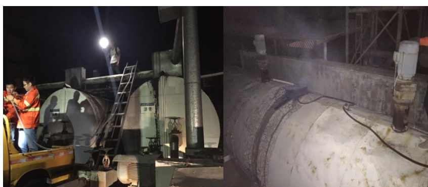
图 E.4 油剂型易密实添加剂添加至沥青储存罐
