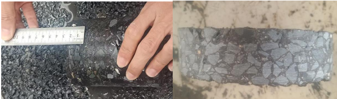
图 E.6 钻芯取样照片
