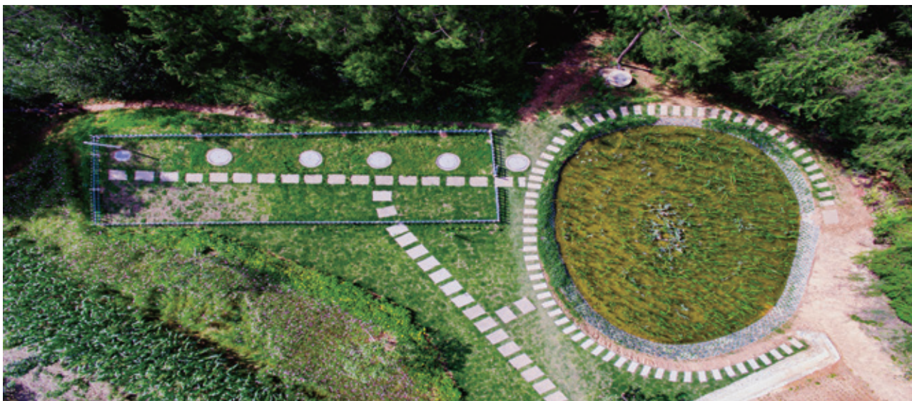
苍溪县五龙镇三会村的污水集中处理设施
