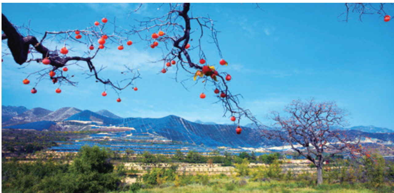
芮城光伏领跑技术基地 高亚平摄
