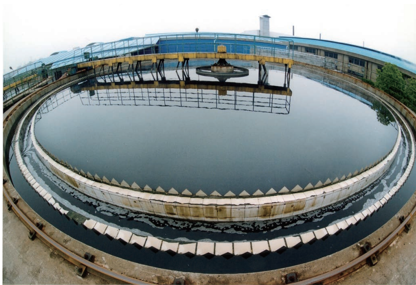
江苏太湖流域现已建成投运 169 座城镇污水处理厂
