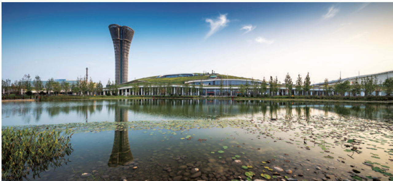
雄安新区垃圾综合处理设施项目
