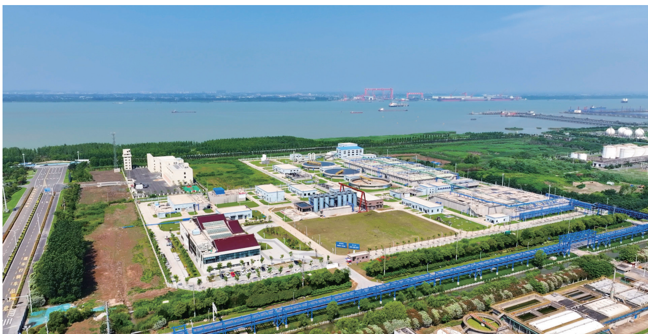
园区污水处理厂
