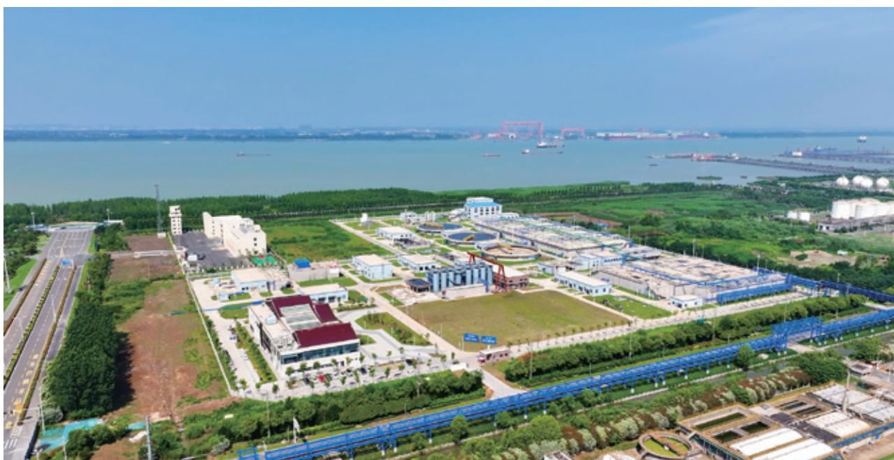
园区污水处理厂
