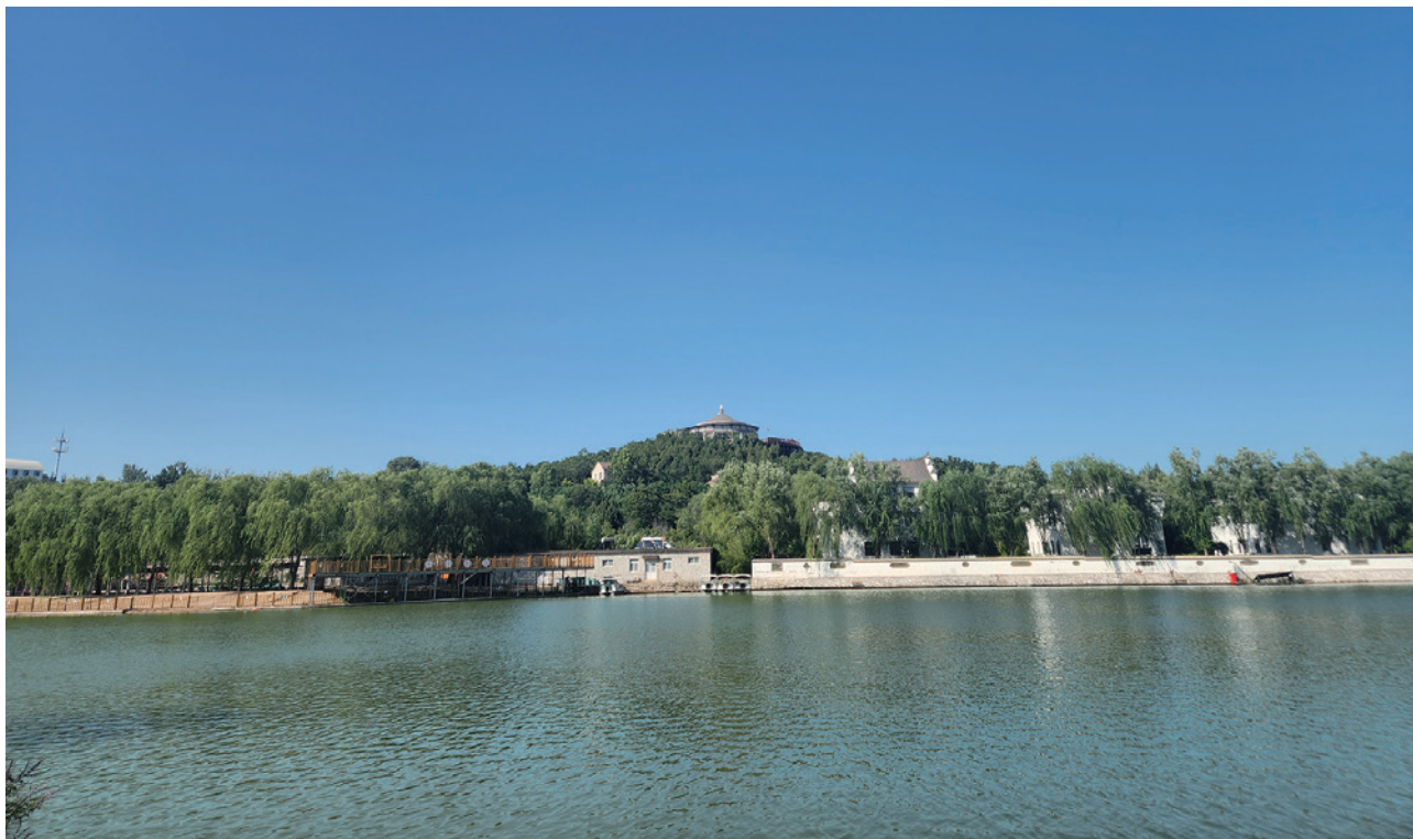
北京房山龙门口水库
