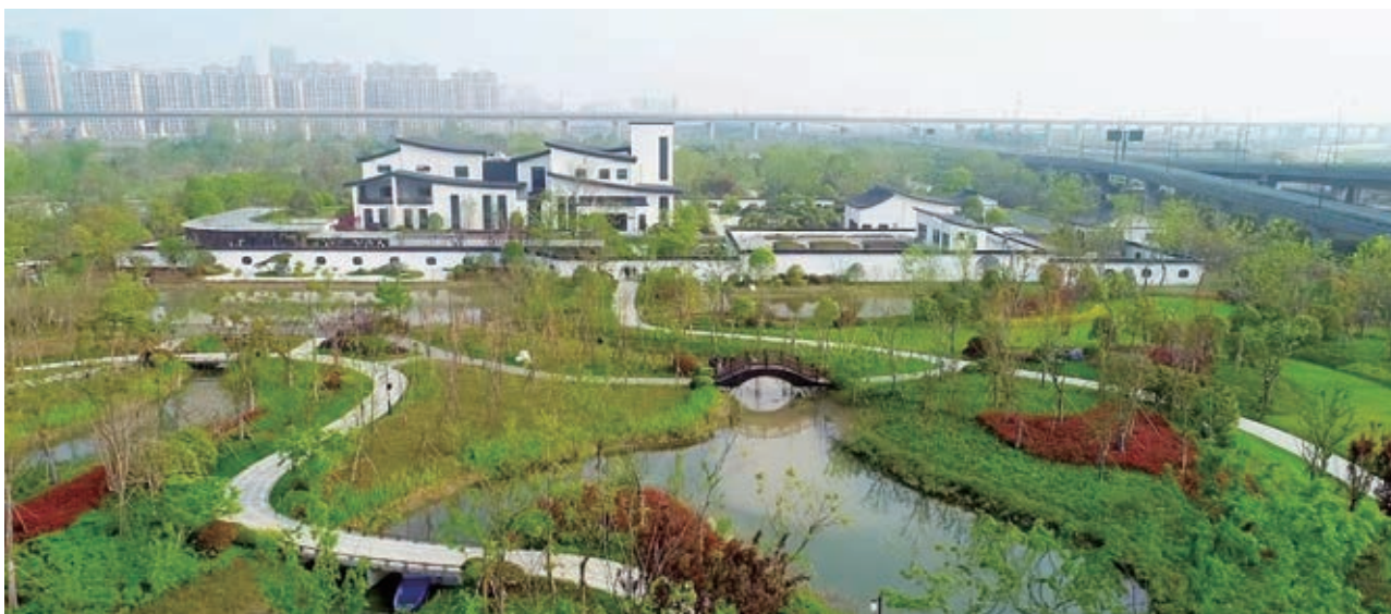
杭州临平净水厂
