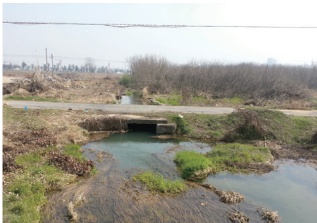
◎ 西苕溪内河湿地治理前
