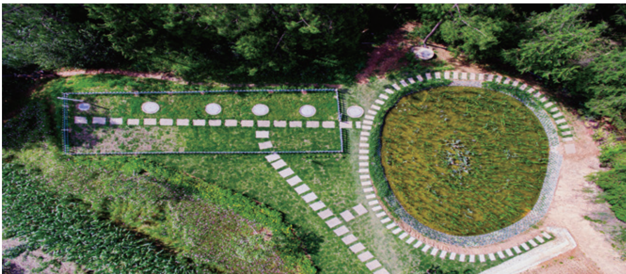
苍溪县五龙镇三会村的污水集中处理设施 王伟/摄
