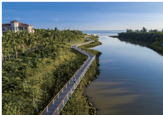
◎五源河岸坡治理后
