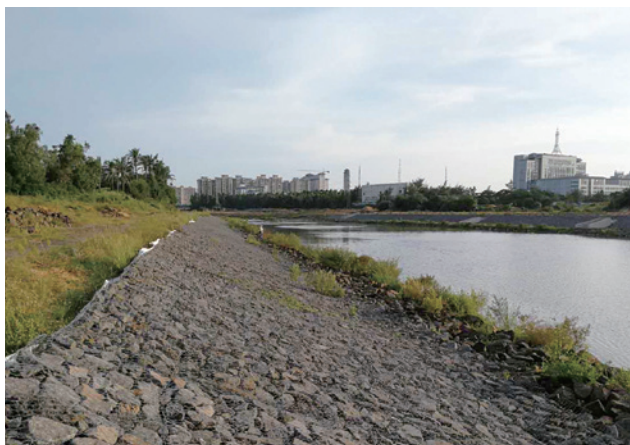
◎五源河岸坡治理前
