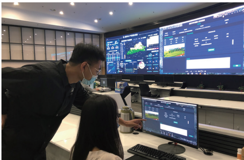
西安市智慧环保综合指挥中心工作人员正在通过环保烟火监管系统进行指挥调度
