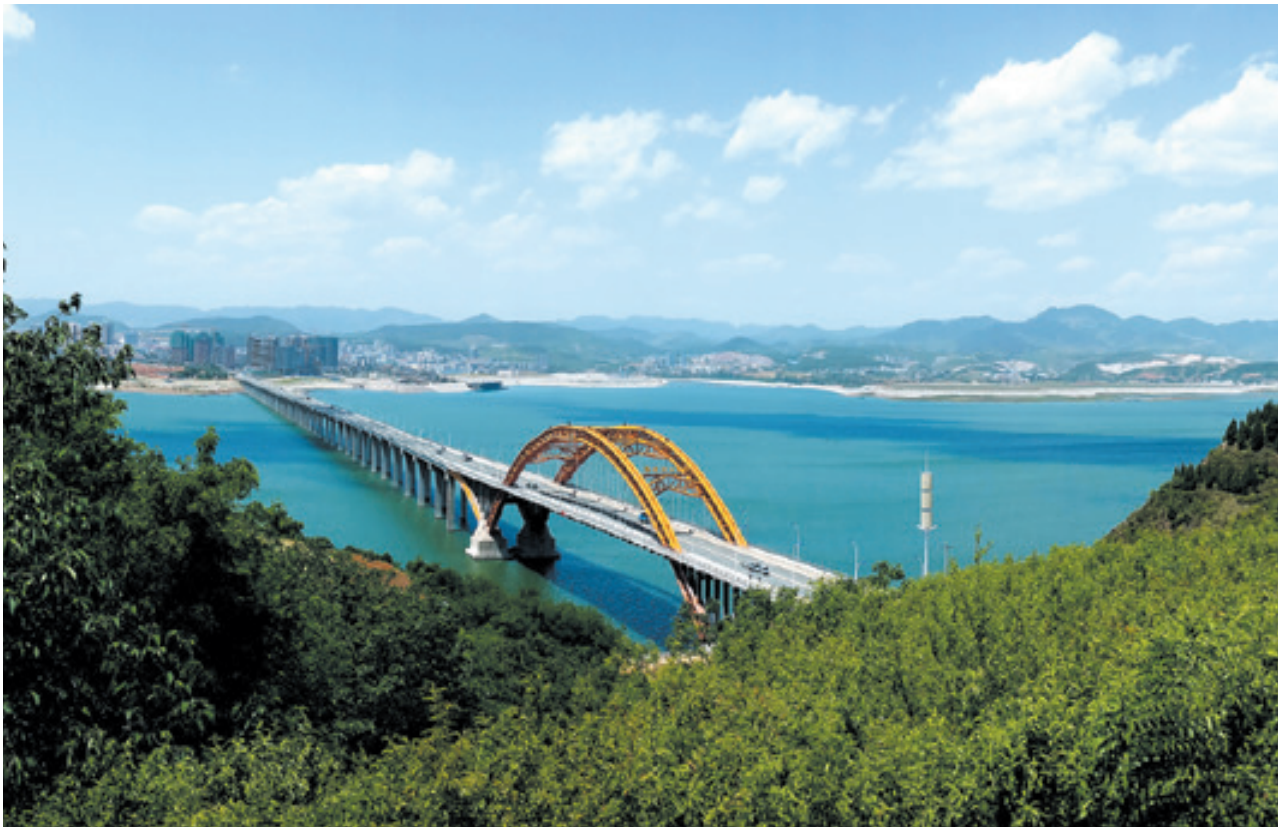
郟阳汉江大桥
