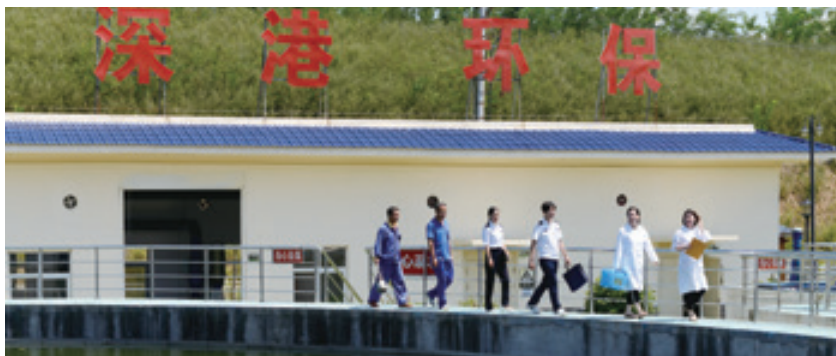
深港环保在十堰建设的水质净化厂
