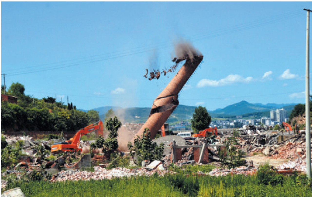
拆除郟阳造纸厂
