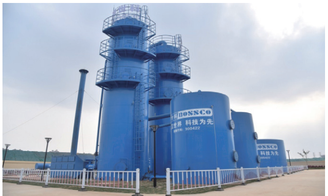
博世科自主设计生产的地下水处理系统BPOS
