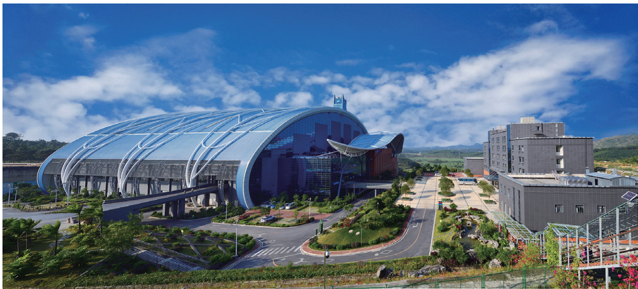
广西南宁环保发电厂（2000 吨/天）
